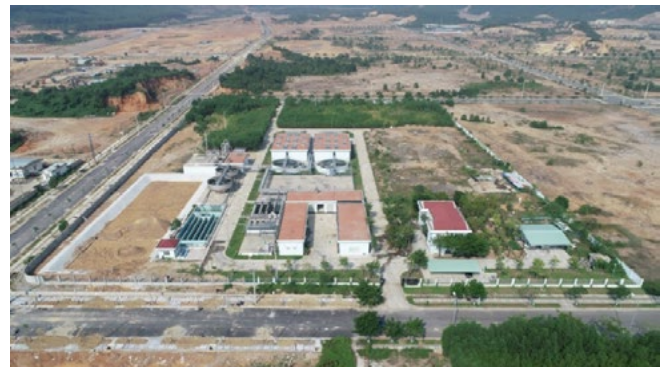
โรงงานบำบัดน้ำเสีย 18.000m 3 / วัน.คืบ
